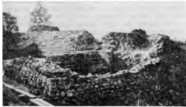
179. att. Martiņsalas pils aizsargmūris ar torņa pamatiem.
